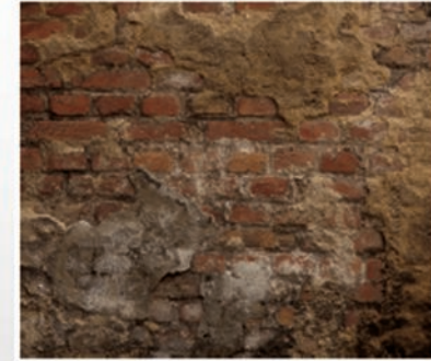
1. Innenputz an der entsprechenden Stelle entfernen.
