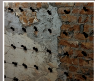
3. Packer in die Bohrlöcher schlagen.
