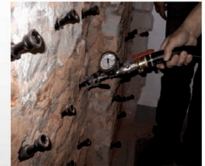
4. Gel im Niederdruckverfahren in die Wand injizieren.
