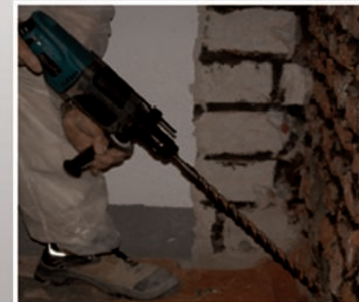
2. Bohrkanäle bis in die Mitte des Mauerwerks erstellen - 45°
